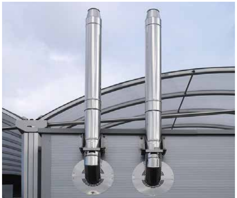
Bild 19: Kaminrohre erreichen im Inneren Temperaturen bis zu 650 °C (Foto: EKA-Edelstahlkamine GmbH, Untersteinach (D))
