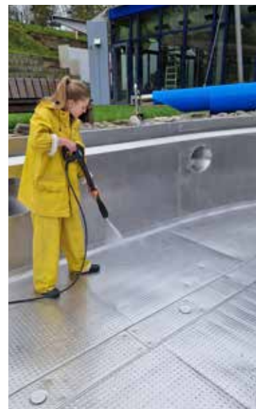
Abbildung 15: Reinigung eines Schwimmbeckens aus Edelstahl mit Hilfe eines Hochdruckreinigers
