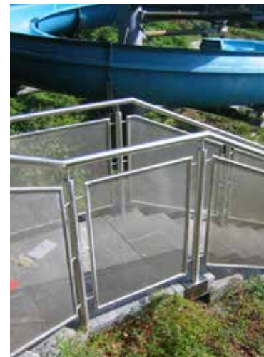
Abbildung 21: Treppenanlage aus nichtrostendem Stahl
