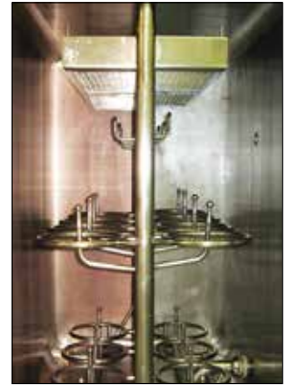
Abbildung 24: Rouging-Effekt an einer Waschmaschine in der Pharmaindustrie; vor und nach der elektrochemischen Reinigung
