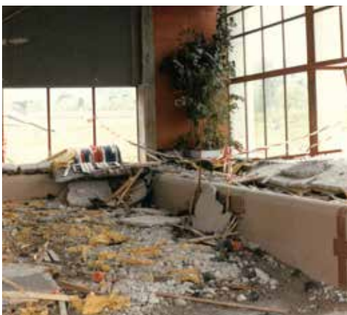
Abb. 7: Schweres Unglück im Hallenbad Uster (Schweiz) im Jahr 1985, bei dem wegen des Einsturzes der Zwischendecke zahlreiche Menschen zu Tode kamen. Ursache war Spannungsrisskorrosion an den Aufhängungsbügeln aus Cr-Ni-Stahl (CRC II). Die Oberflächen der gebrochenen Bügel zeigen unterschiedlich stark fortgeschrittene Korrosion. Der rechte Bügel zeigt eine starke Einschnürung mit typischer Gleitbruchfläche und hat vermutlich am längsten getragen. Beim mittleren Bügel ist eine geringe Einschnürung noch erkennbar.
